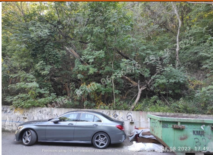
Склонов участък по пътя между градовете Чепеларе и Асеновград и регламентирано събиране на отпадъци (т. FID-111)
